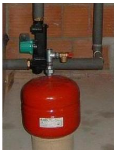
Slika 6.17 Izgled i šematski prikaz zatvorenog ekspanzionog suda sa membranom
