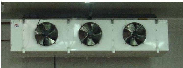
Slika 7.7 Izgled isparivača za hlađenje vazduha
