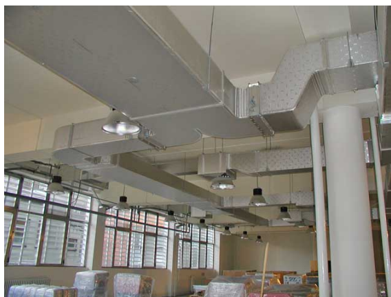
Slika 3.7 Primeri delova izvedenih kanalskih mreža
