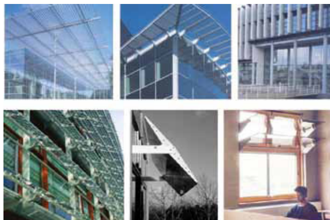
Slika 6.26 Primeri spoljnih elemenata za zaštitu od Sunčevog zračenja
