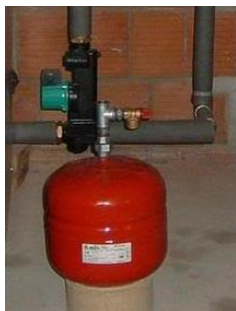
Slika 4.17 Izgled i šematski prikaz zatvorenog ekspanzionog suda sa membranom
