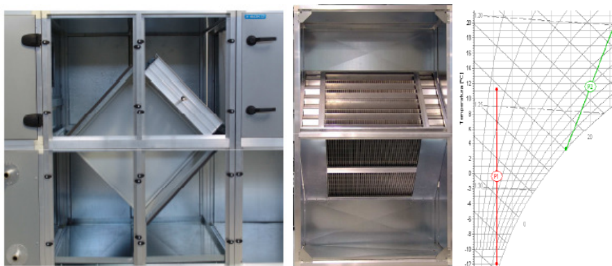
Slika 10.3 Pločasti rekuperator i promena stanja svežeg i otpadnog vazduha
