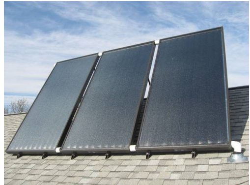
1 – Apсорber; 2 – Prekrivka; 3 – Izolacija; 4 – Bakarna cev Slika 6.26 Ravan prijemnik Sunčeve energije
