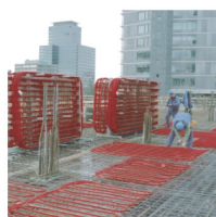
Temperiranje betonskog jezgra
