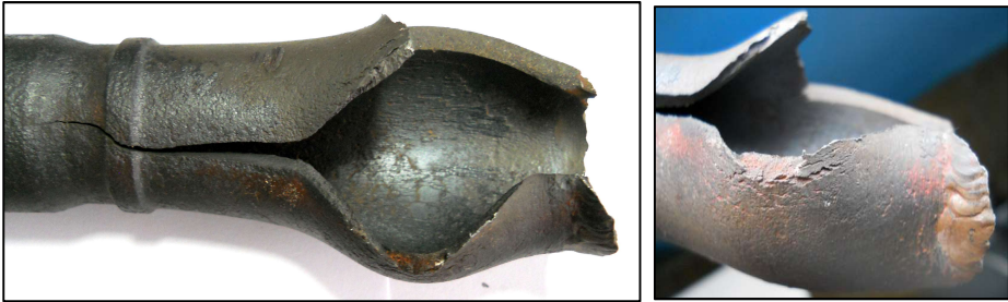
9.28: Lom usled puzanja cevi u zoni zavarenog spoja
