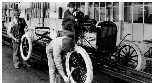
Slika 8. Prva montažna traka za masovnu proizvodnju automobila (Ford Model T), Fordova fabrika Highland (Michigan, USA, 1913. godina)
