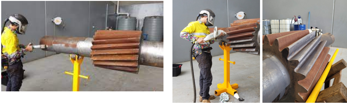
Slika 6 Čišćenje korodiranog vratila sa zupčanicom laserskom metodom
