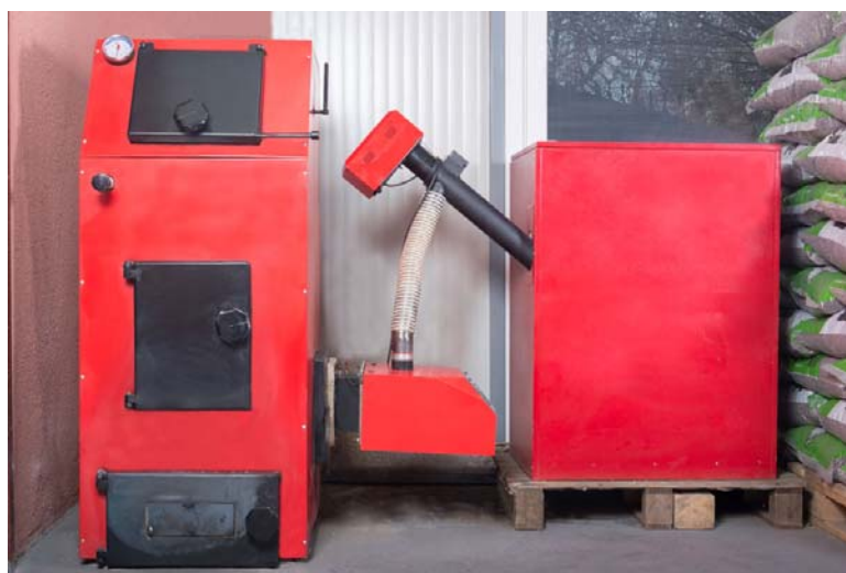
Слика 8.4. Котао на пелет са спољним гориоником
