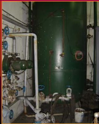
Технолошка шема топлане – експанзиони суд за одржавање притиска
