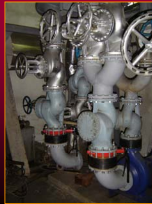
Технолошка шема топлане – циркулационе пумпе
